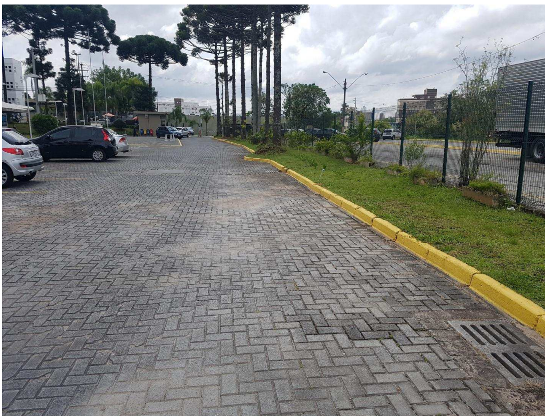
Rede pluvial existente em frente ao Fórum – Tirar tampa de boca de lobo e realizar limpeza da caixa e hidrojetamento da tubulação
