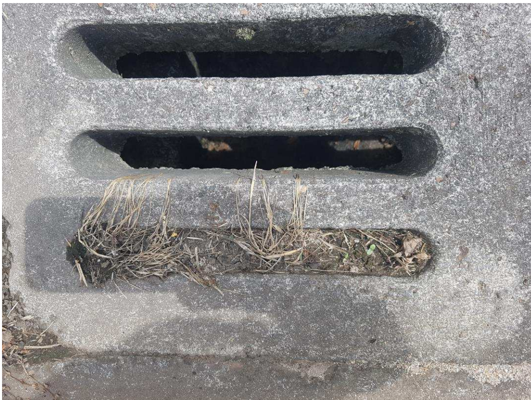
Limpeza das caixas pluviais
